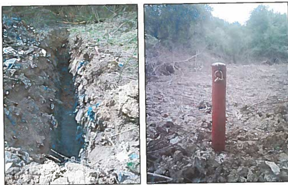
Figure n°11 : Aperçu du transect et piège à lixiviat.
