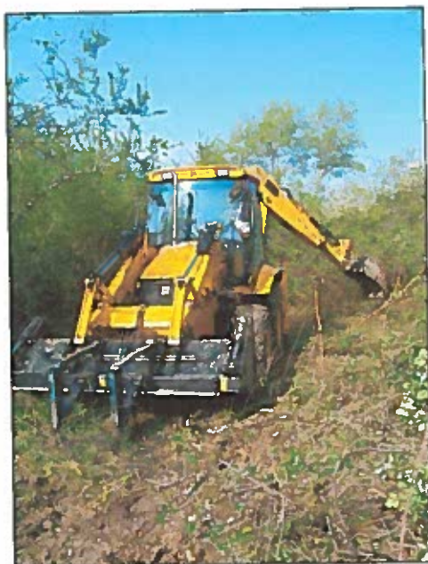
Figure n°10 : Débroussaillage du site.
